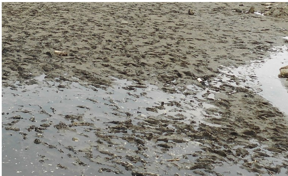
(Fig.1 導流堤の最も西側にある水門の七北田川に面した側)
