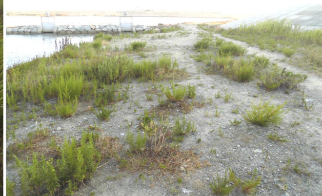
(Fig.4 潟湖護岸の段差上部)
