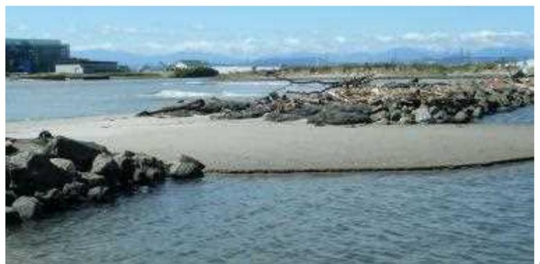
(Fig.7 砂が堆積した導流堤)
