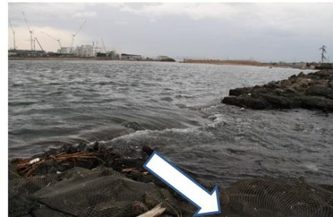
Fig.3 満潮時の導流堤の通水部分
