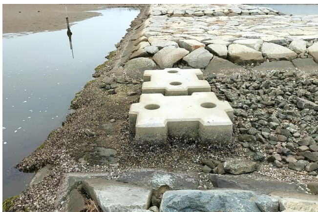
Fig.2 導流堤付近(St.11)の様子
