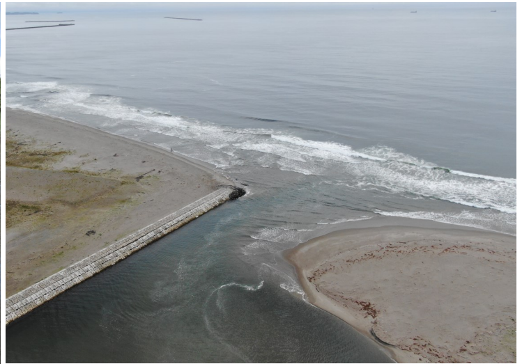
Fig.4 七北田川河口右岸砂州（ドローン撮影）
