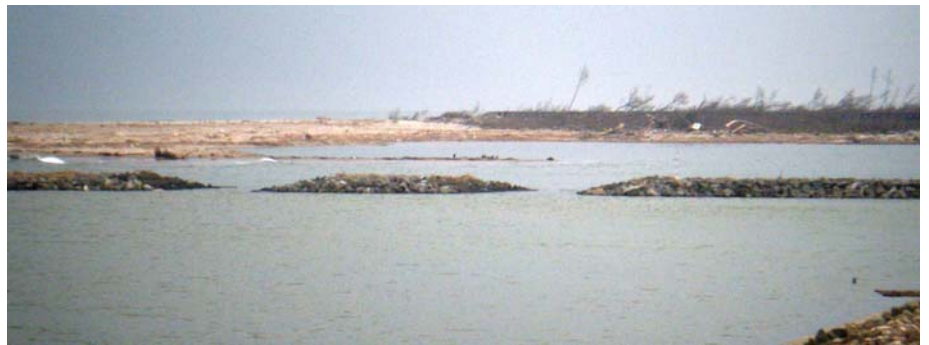
Fig.2 現在の導流堤
