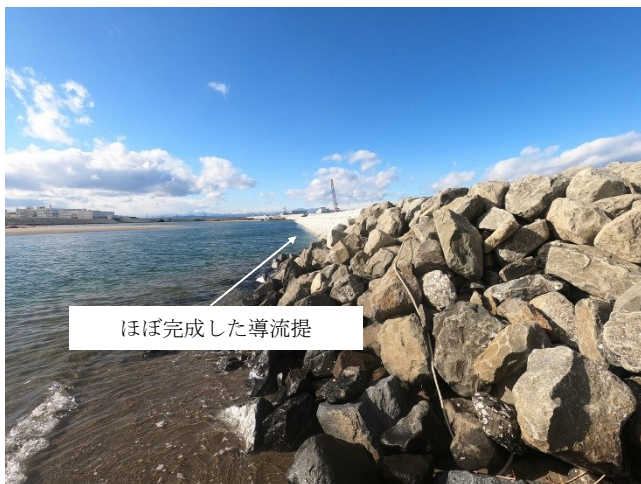
Fig.3 導流堤東端（東側から撮影）
