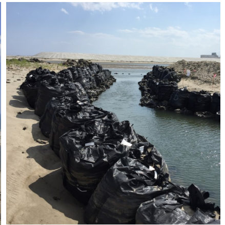
Fig.4 通水部分 (北側より撮影)
