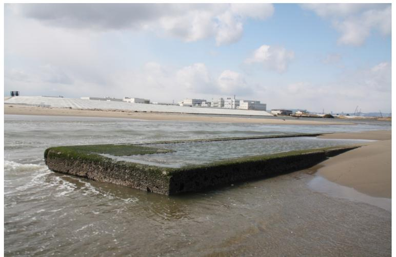
Fig.4 むき出しになった護岸ブロック
