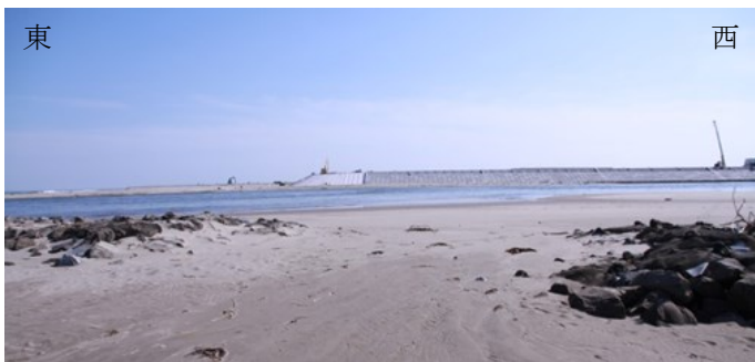
Fig.2 堆積により閉鎖した、東側の通水部分
