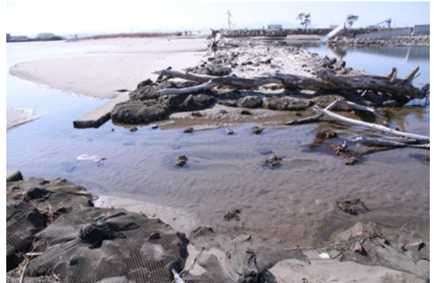
Fig.4 堆積が進んでいる 中央の通水部分
